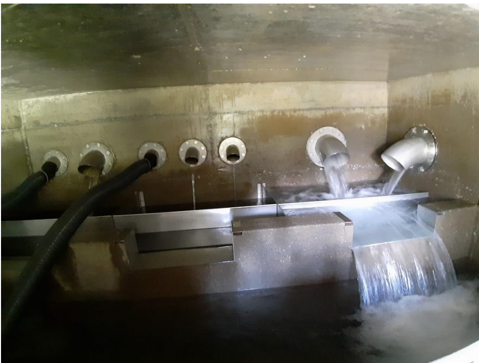
Abb. 2: Blick in die Quellstube der Oberfercherquellen 3-9 mit den 7 Zuläufen (links im Bild die ausgeleiteten Quellläste 3 und 5)
